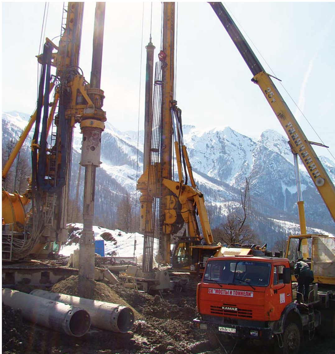
На строительстве дорог в Сочи задействована самая современная техника.
